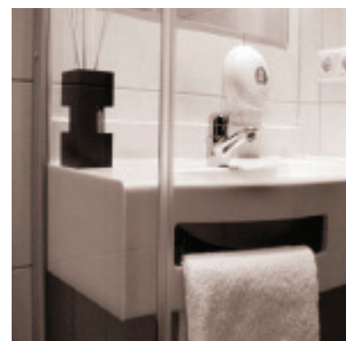
Direkter Anschluss des Waschtisches an die Glasduschabtrennung
