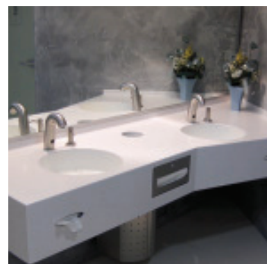
Öffentlicher Toilettenbereich: Doppelwaschtischanlagen mit Auflage- bzw. Unterbaubecken mit zusätzlichen Ablageflächen und Funktionsausschnitten
